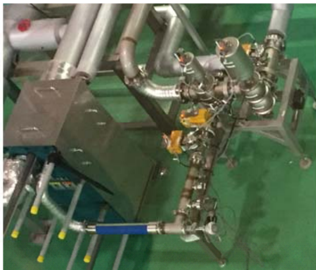
(写真 2) ラインに設置された温度センサー
