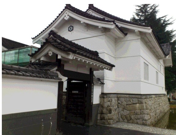
写真 1 御用蔵の外観
